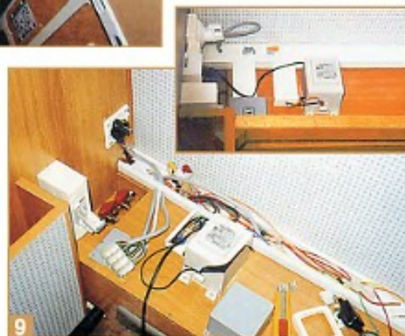
Салон на разных этапах монтажа электросетей. Остается только подключить электроприборы.
