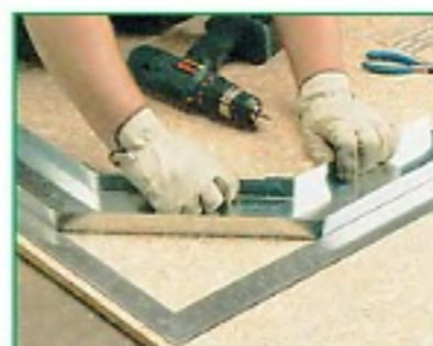
Профиль гнут с помощью металлического угольника.
