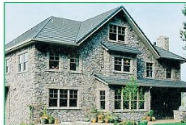
После облицовки искусственным камнем прекрасный дом стал ещё красивее. Обратите внимание на аккуратные камни, которые выделяют окна.
