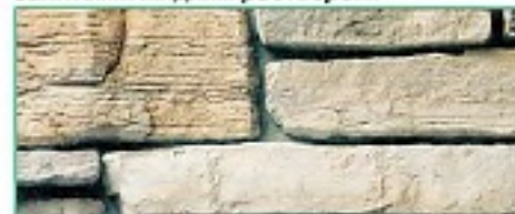
Прямоугольный камень со швами, залитыми жидким раствором.
