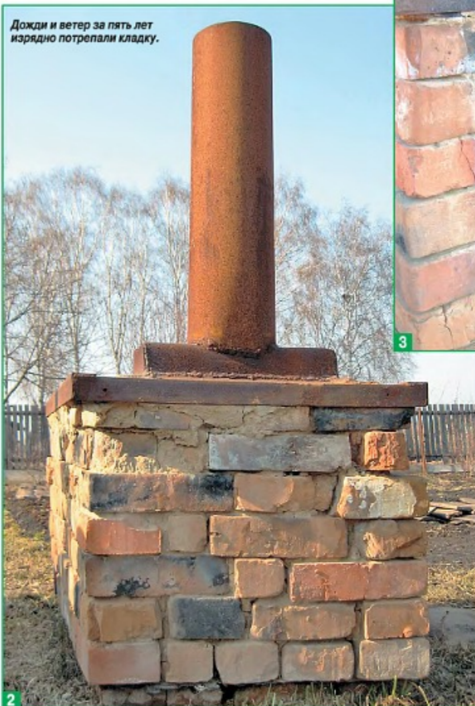
Рис. 3. Верхняя обвязка дворовой печи в сборе с дымовой трубой.
