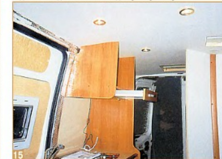
Каждый шкафчик и полка находит свое место. Никаких необработанных торцов фанеры не должно быть видно после того, как мебель установлена на место.
