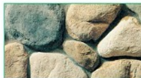
Бесформенный камень со швами, залитыми жидким раствором.
