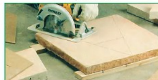
По индивидуальным шаблонам делают разметку плит оголовка и выпиливают их алмазным диском.
